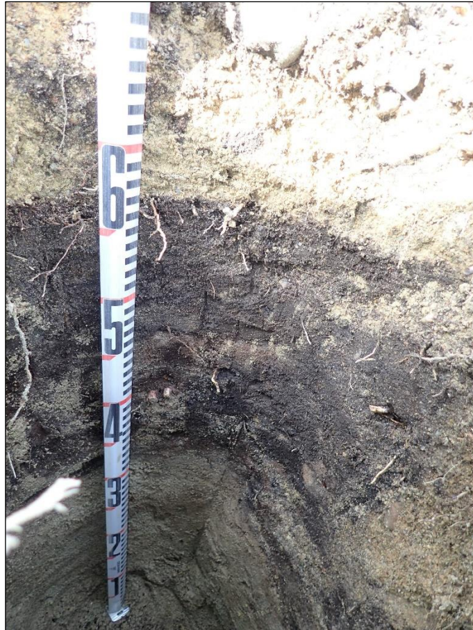
Koekuopan 9 leikkaus. Tien perustamiskerroksen alla tumma orgaanisen aineen kerros, joka on todennäköisesti kerrostunut hyvin matalaan rantaveteen.
